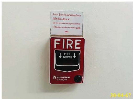
อุปกรณ์แจ้งเหตุเพลิงไหม้ด้วยมือ (Manual Station)
