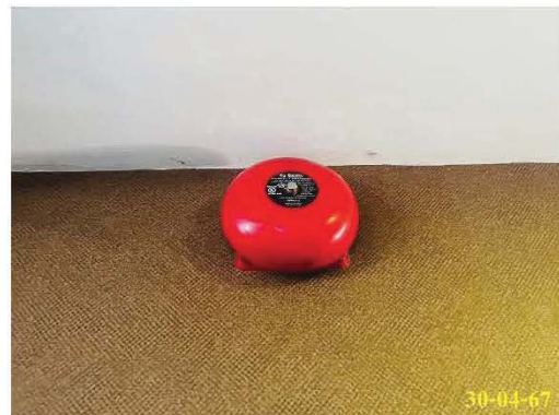
สัญญาณแจ้งเหตุเพลิงไหม้ (Fire Alarm Bell)
